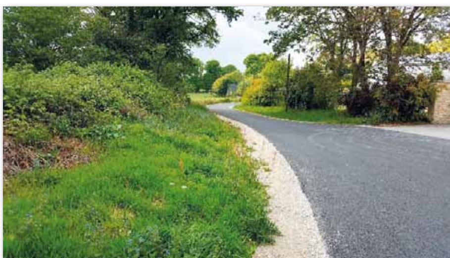
Tapis d'enrobé et accotements sur la route de "Kerhallec"
