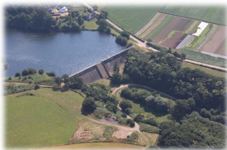
Photo du barrage de Trégat - Source : Comité Français des barrages et des réservoirs (CFBR)
