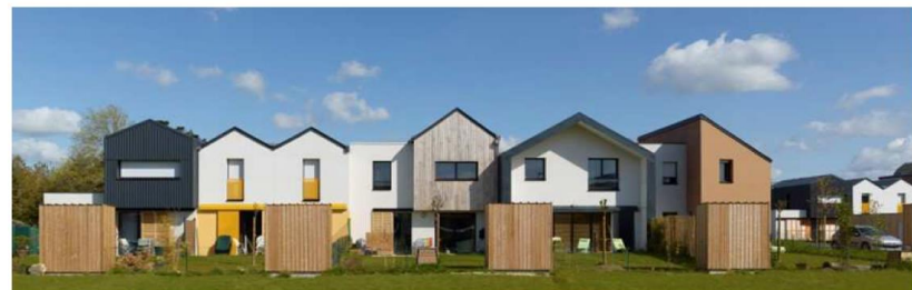
Opération groupée « Vert Buisson » à Bruz (35)
